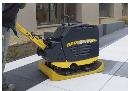
Aucune rupture des pavés
